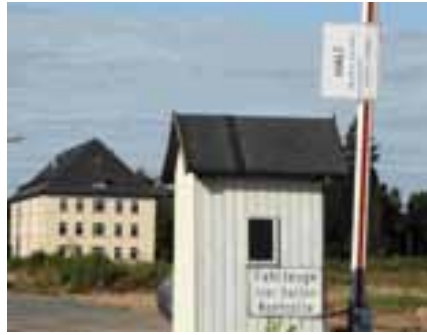
Die Kasernen wurden in den Jahren 1934 und 1935 erbaut
