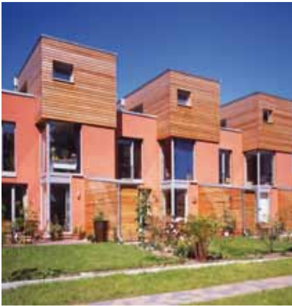
Zeitgemäße Stadthäuser im Passivhaus-Standard in Hamburg-Heimfeld
