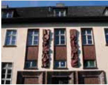
Ein Teil der ehemaligen Kasernen wurde unter Denkmalschutz gestellt
