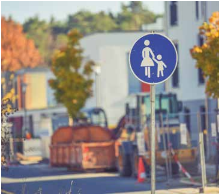
Offene Baustelle ab Januar 2017: bitte nehmen Sie Rücksicht
